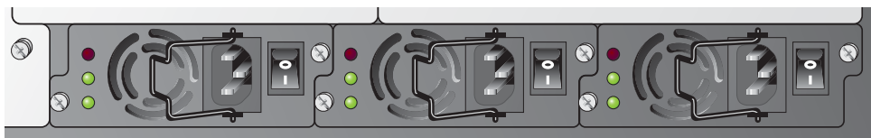
圖 7 400 W 電源供應模組已安裝
